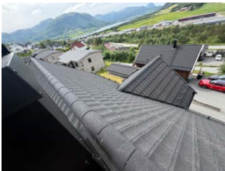
Oversiktsbilde av takteking, ingen avvik påvist.
