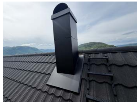
Skorstein over tak.
