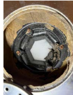
Originalt sluk fra 1988 med rustne skruer til klemring
