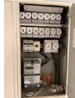
Elskap med skrusikringer, plassert i fellesgang.
