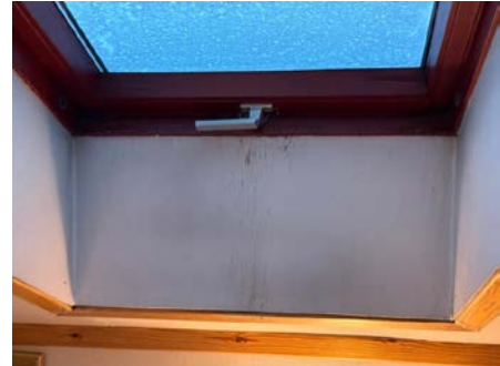
Eldre lekkasjemerker under et takvindu
