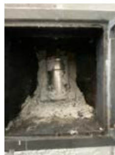
Sotluke på stålpipe inne på liten stue.
