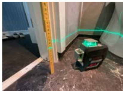
Kontrollmåling fallforhold, topp belegg ved dør.
