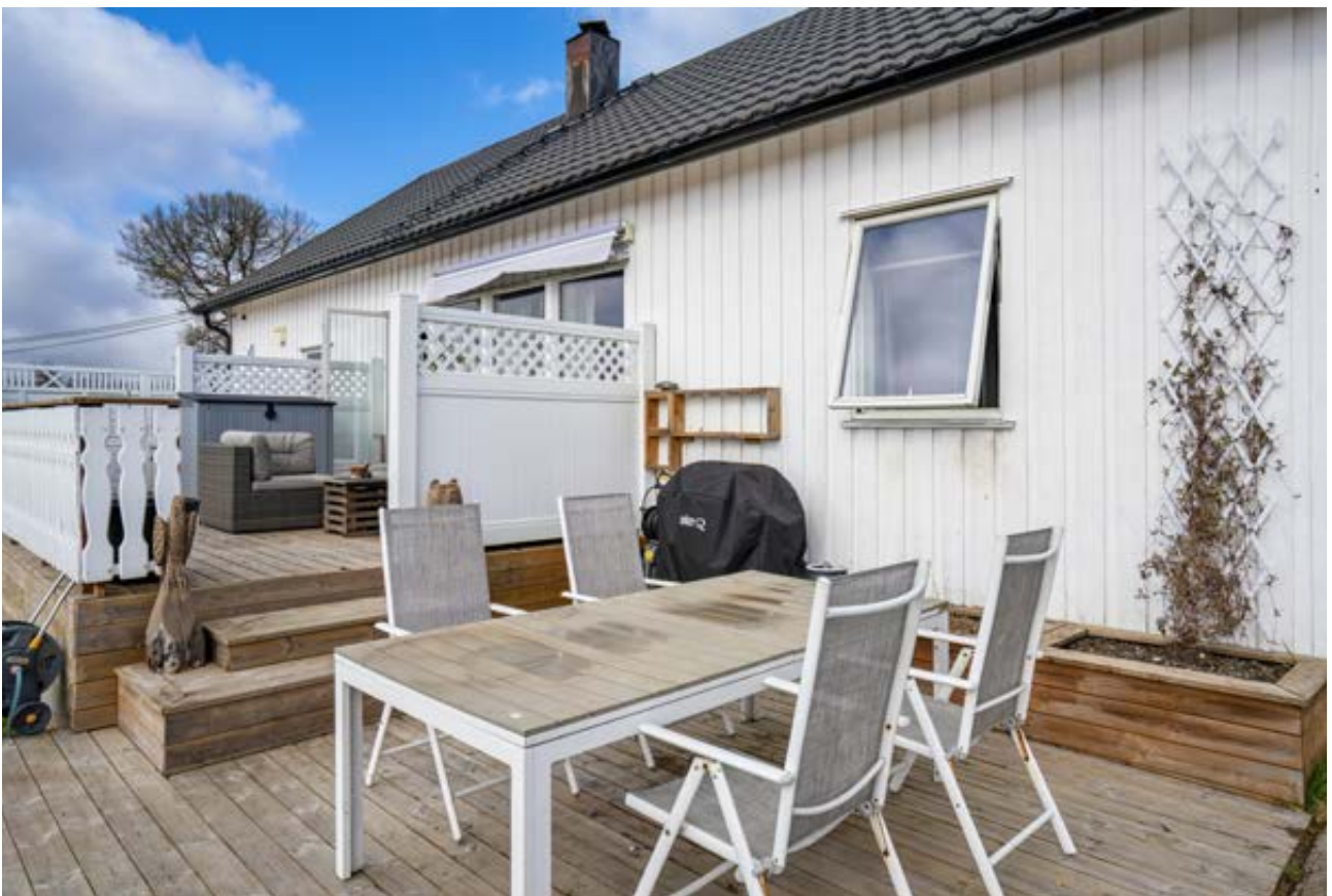
Plattingen med tretrapp opp til terrassedelen
