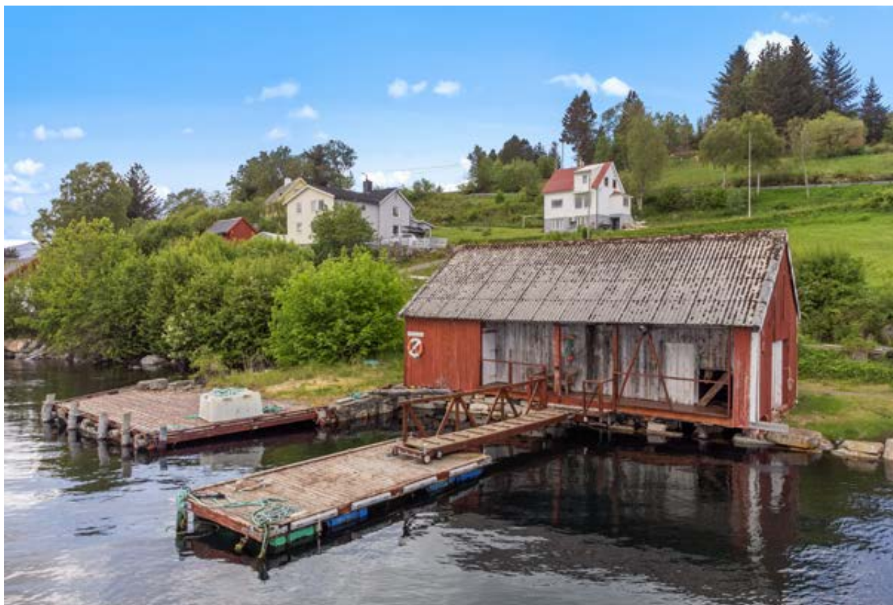
Fasade naust med kai og flyttebrygge
