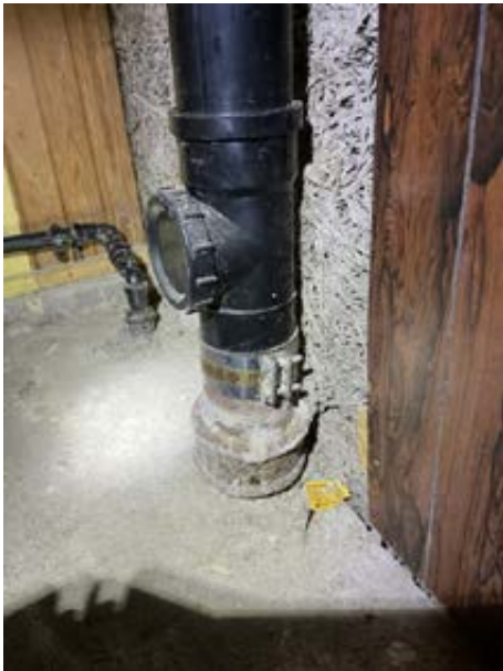
Avløp fra bolig er tilkoblet rør i støpe-jern (stikkledning).
