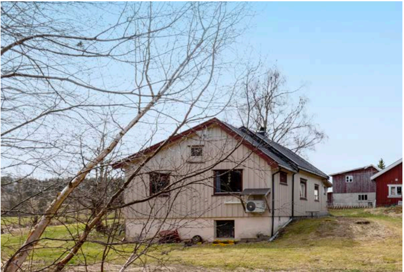
Eldre enebolig som er påbygd stue og soverrom med krypkjeller
