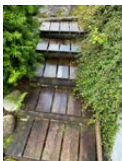
Trappetrinn i tre - montert mot terreng
