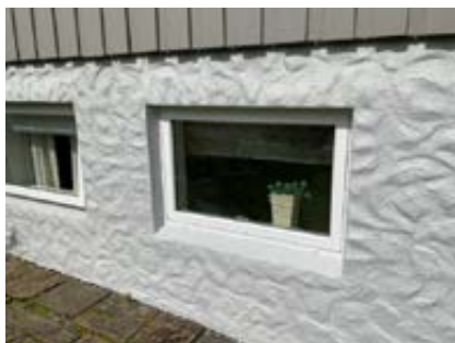
Kjellervindu uten beslag underkant
