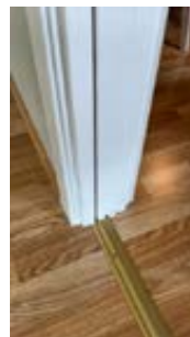
Metallist hindrer bruk av skyvedør
