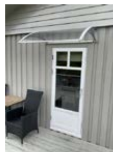
Altandør stue, PVC - oversiktsbilde
