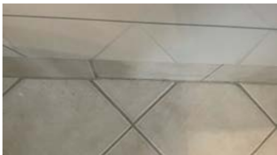
Skjevhet sokkelflis (underliggende hul) jf. eier)
