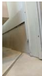
Gliper fuge mellom sokkelflis og baderomsplate
