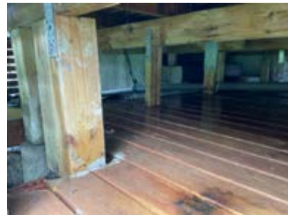
Understøttelser og eldre platting under
