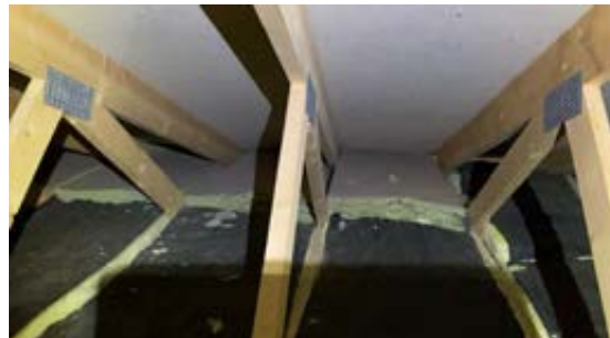
Isolasjon lagt mot undertak
