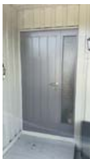
Dør til platting bakside - oversiktsbilde
