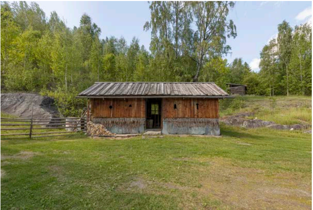
Dette uthuset/skjulet er nytt, men bygd med mange gamle håndverksteknikker. Det er bygd som et bindingsverkshus, med avstivninger av rotkne, kalt grindbyggkonstruksjon.
