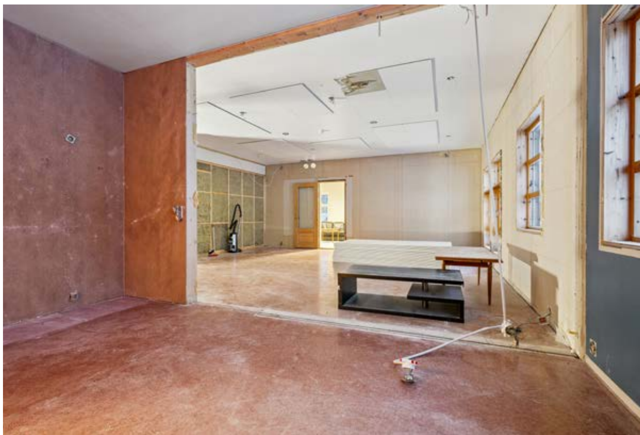
Under renovering/ombygging til fritidsleilighet
