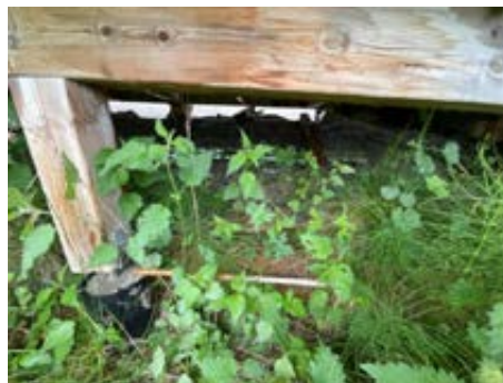
Støpte pilarpunkt og opplegg av tre ned mot bakkeplan
