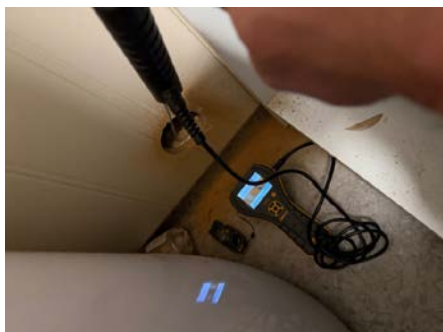
Hulltaking og fuksøk i rom under terreng. Ikke utslag på fukt.
