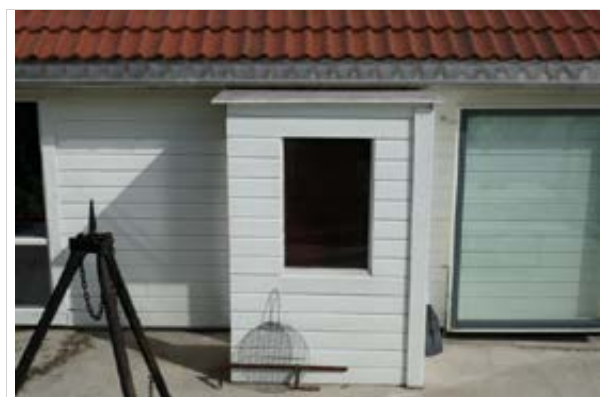
Vindfang med tretak foran inngang-/sidedør.
