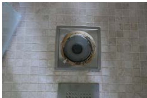
Sluk på bad i 2. etasje.
