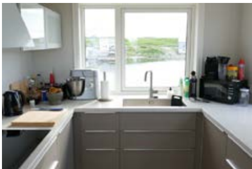
Kjøkken i hoveddel. Benkeplate ligger noe høyere enn vinduspost.
