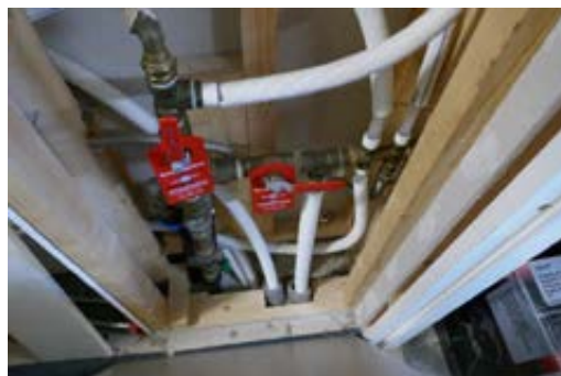
Stoppekrane er plassert i garasje.
