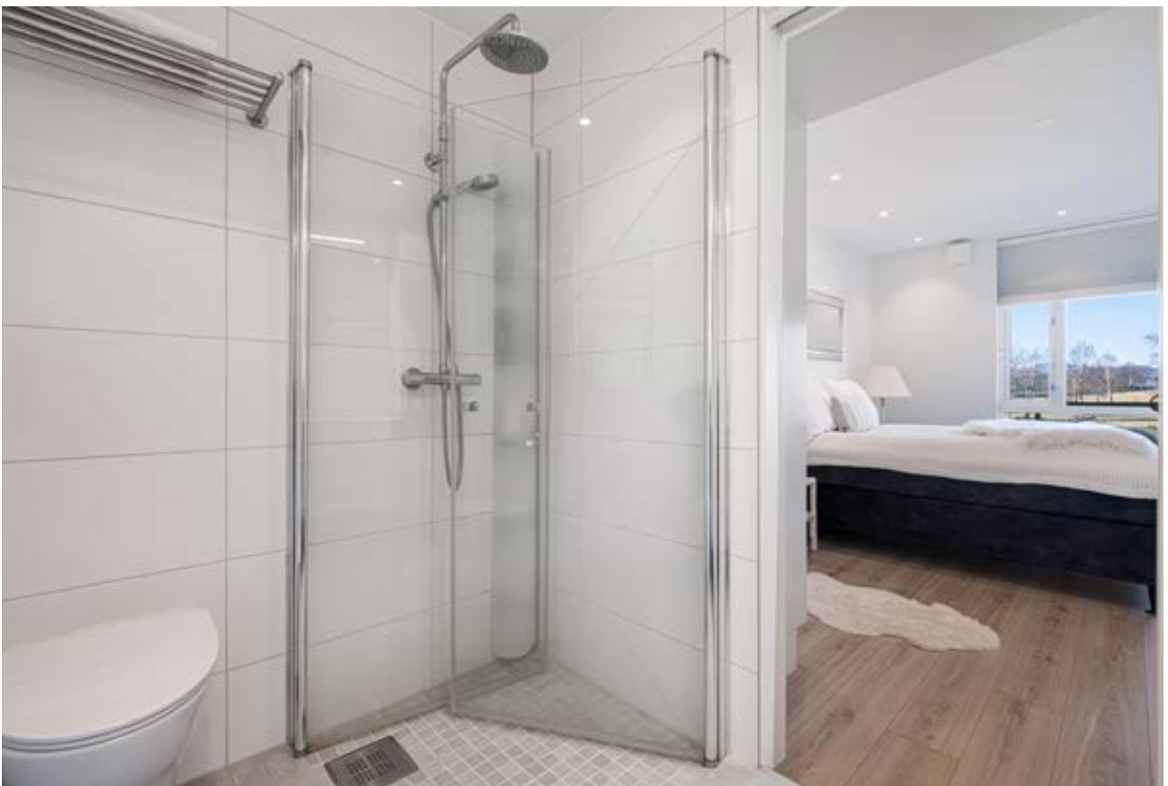
Fra badet - her er varme i gulv - vegghengt wc og dusjhjørne
