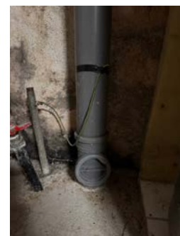
Soillrør med stakeluke i kjelleren.
