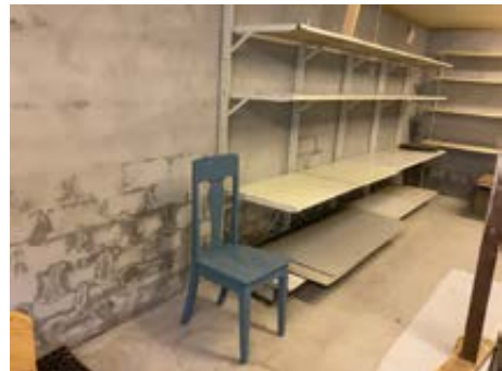
Spor av fuktighet på mur/gulv i kjeller.
