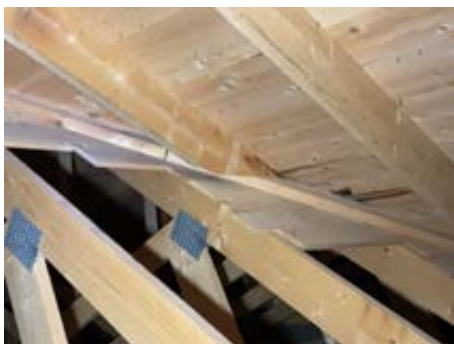
Fuktmerker på trod i gradrenne.
