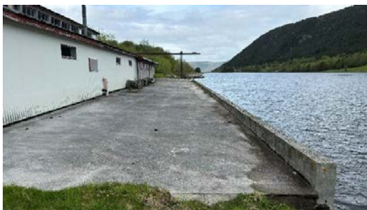
Stor kai med betongdekke.
