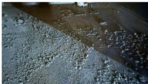
Saltutslag og sprekkdannelse på gulvet
