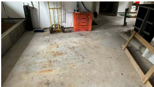
Betonggulv på store deler av bygningen.
