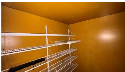
Slette malte plater i store deler av bygget.
