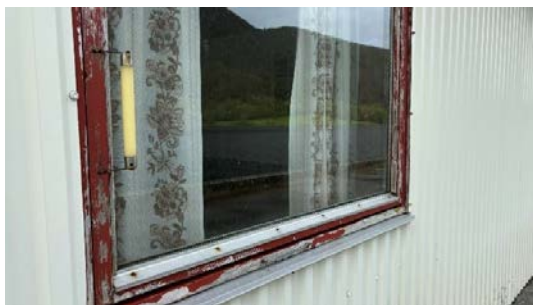
Større værslitasje på de fleste vinduer utvendig.
