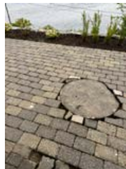
Belegningsstein ligger noe ujevnt.
