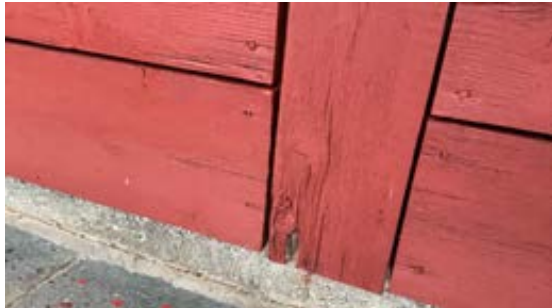
Spredte råteskader
