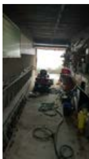
Lysplater på vegger, plank mot terrasse over
