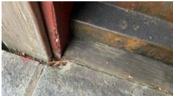
Fukt/råteskade garasjedør
