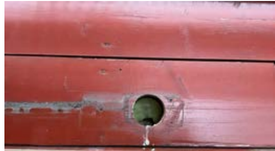
Åpent mot veggkonstruksjon
