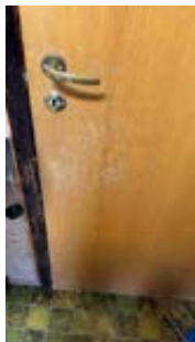
Vaskerom - sltiasjegråd overflate
