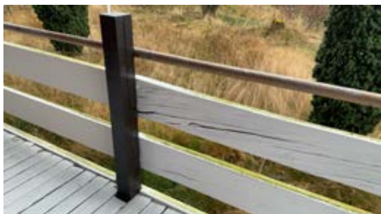
Fukt/råteskader
