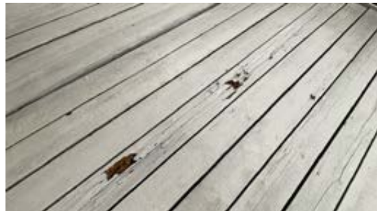
Fukt/råteskader
