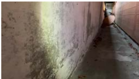
Konstruksjoner mot grunnen bak bolig
