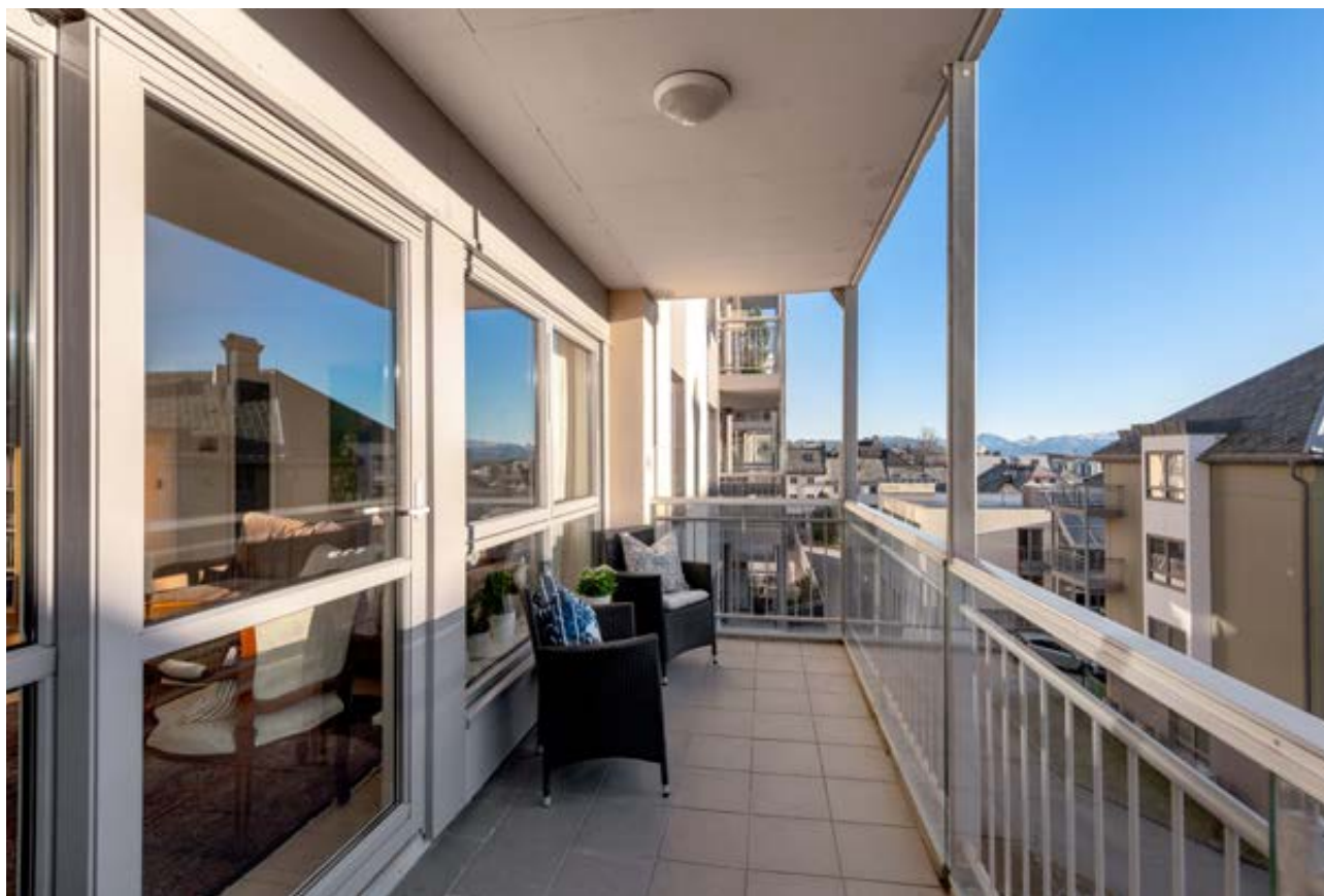
Fra veranda som er delvis overbygd. Den er overbygd, ikke bare delvis. Får med at det er montert pleksiglass og at det er flislagt dekke
