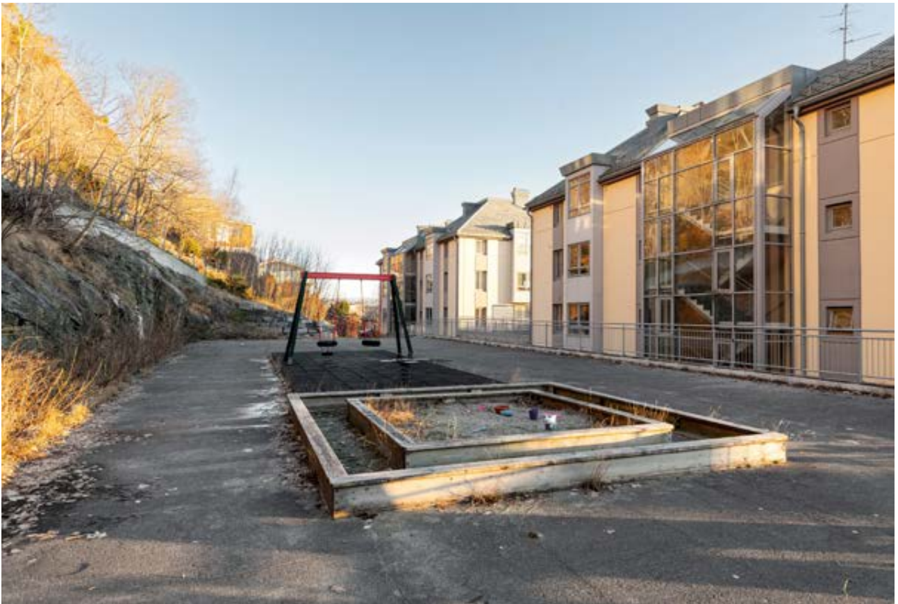
Det er lekeplass på nordsiden av bygget
