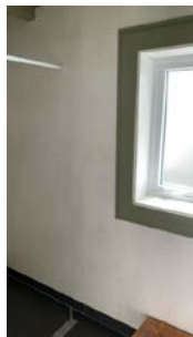
Vindu i våtsone, kledningsbord som listverk
