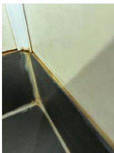
Ikke brukt bunnprofil for baderomsplater
