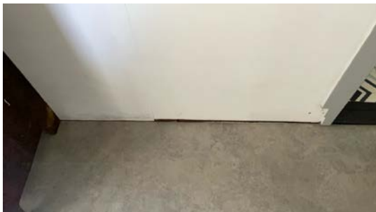
Stedvis gjenstående arbeid
