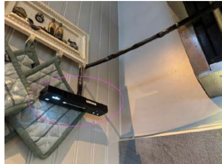
Betjeningsdisplay henger provisorisk på en knapp.
