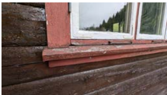
Vinduene i hytta har kort gjenværende levetid.
