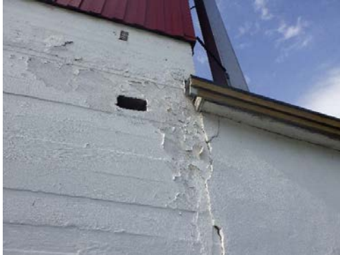
Avskalling og etterhengende vedlikehold av utvendige fasader.
