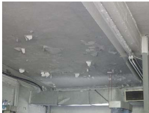
Armerte betongdekker stedvis med tresnitt, og malte overflater.
