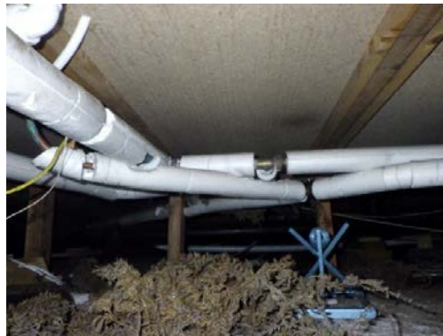
Vann og avløp er delvis lagt skjult under gulvet, og delvis åpent.
