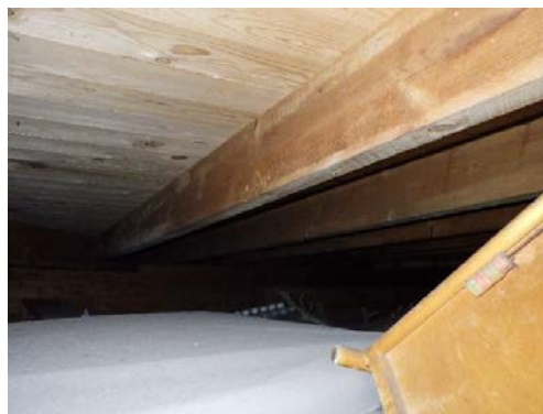
Takkonstruksjon av tresperrer i leilighet.
