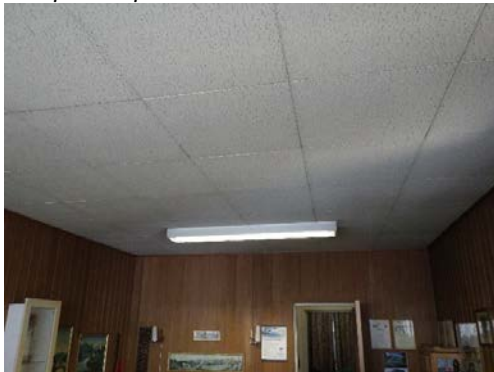
Systemhimling i kontorareal i næringsdelen.
