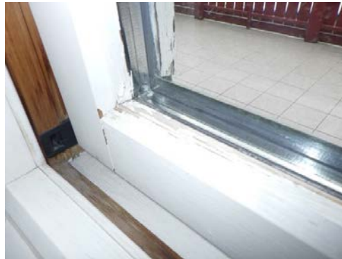
Vinduer i leiligheten bærer preg av stedvis større slitasje, og etterhengende vedlikehold.
