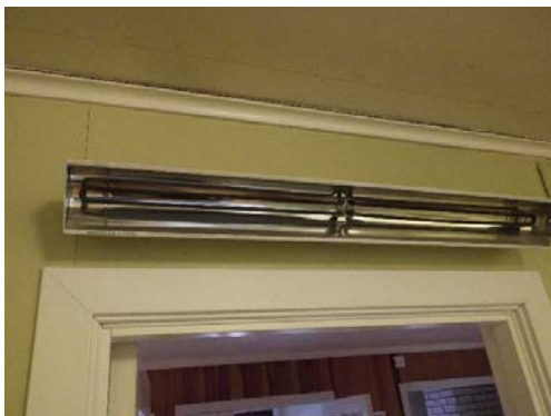
Varmepumpe som betjener stuen.
