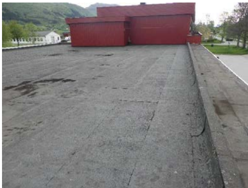
Taktekking av asfaltmembran på bygningsmassen.
