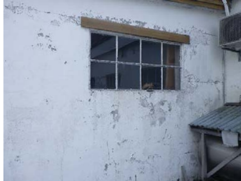
Avskalling og etterhengende vedlikehold av utvendige fasader.
