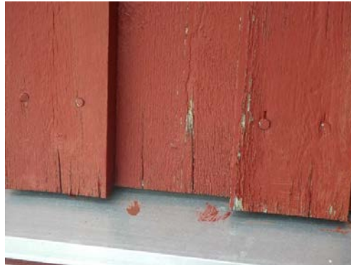
Stedvis større slitasje og påbegynnende råtesakder i enden av bordkledning i leiligheten.
