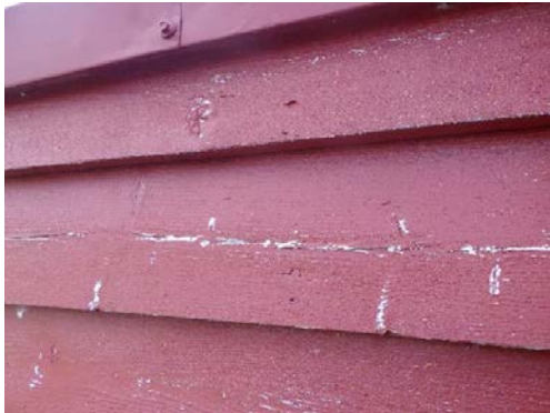
Stedvis større slitasje og påbegynnende råtesakder i enden av bordkledning i leiligheten.
