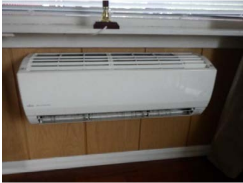
Varmepumpe som betjener stuen.
