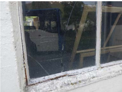
Vinduer i næringsdelen er av enkelt glass og er sterkt nedslitt.
