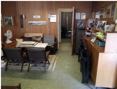
Finerplater på kontorareal i næringsdelen.
