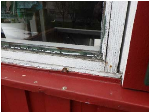
Vinduer i leiligheten bærer preg av stedvis større slitasje, og etterhengende vedlikehold.
