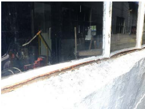
Vinduer i næringsdelen er av enkelt glass og er sterkt nedslitt.
