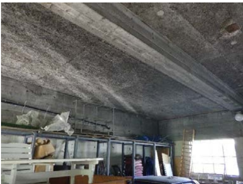
Armerte betongdekker stedvis med tresnitt, og malte overflater.
