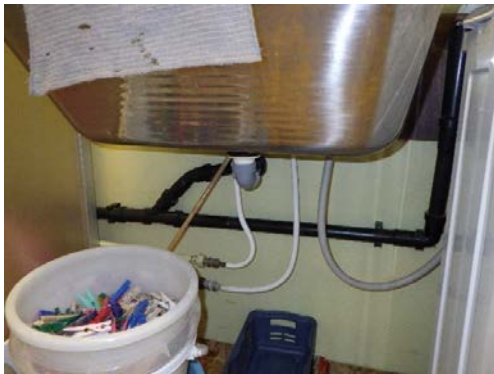
Vann og avløp er delvis lagt skjult under gulvet, og delvis åpent.
