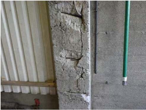
Armeringskorrosjon i søyle og betongdrager i bussgarasjen.
