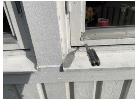
Påvist råteskade
