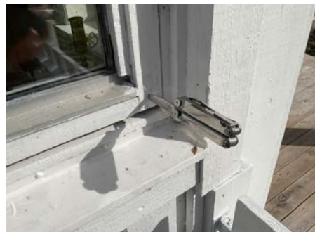
Påvist råteskade
