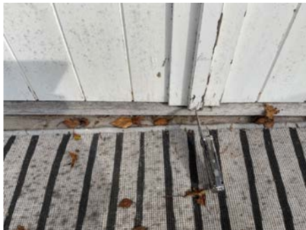
Påvist råteskade
