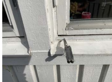
Påvist råteskade
