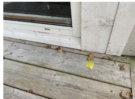
Ikke fagmessig utført, risiko for vanninntrengning
