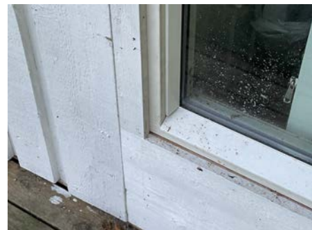
Ikke fagmessig utført, risiko for vanninntrengning
