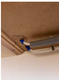
Fuktskjolder i himling og høye fuktverdier.
