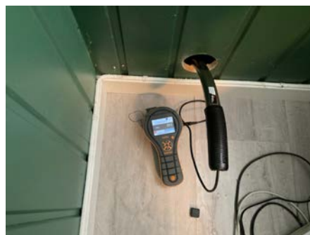
Målt fuktinnhold 23,5 vektprosent
