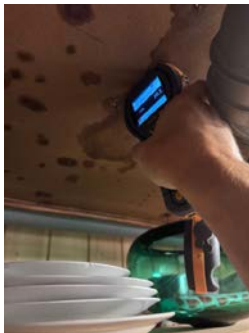
Fuktskjolder i himling og høye fuktverdier.
