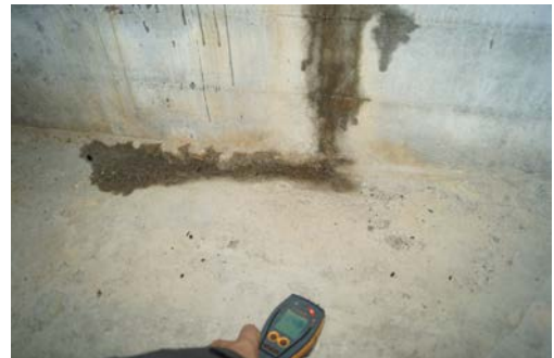
Det er påvist fuktgjennomtrenging inn i kjellermur.
