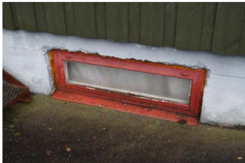
Vinduer i kjeller er fra byggeår
