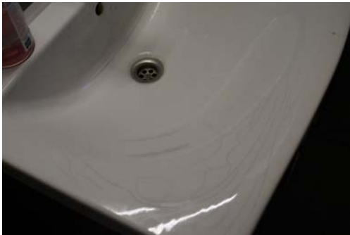
Det er påvist riss/krakelering i servant
