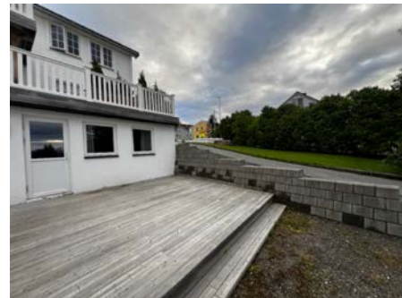
Mangler rekkverk/fallsikring.
