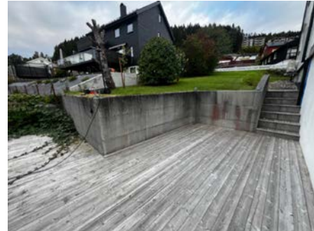
Mangler rekkverk/fallsikring.
