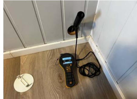
Det var allerede tatt hull i konstruksjonen ved en tidligere anledning.
