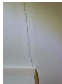
Setningssprekker i 5 veggplater
