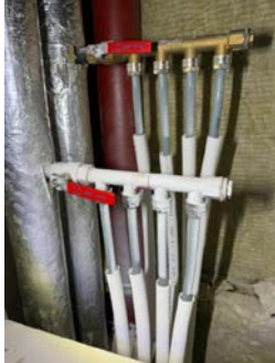
Stoppekraner og rør til fjernvarme bak deksel i stuevegg.
