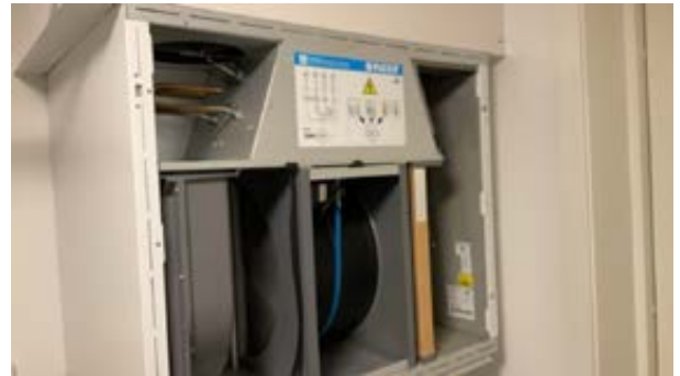
Flexit Nordic S4R balansert ventilasjonsanlegg
