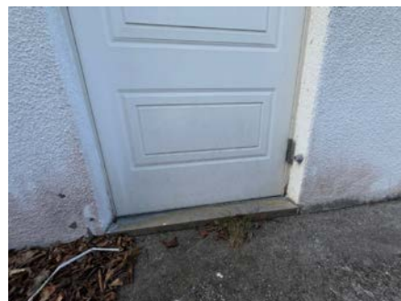
Kjellerdør mot nord.
