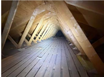
Oversiktsbilde av kaldloftet.
