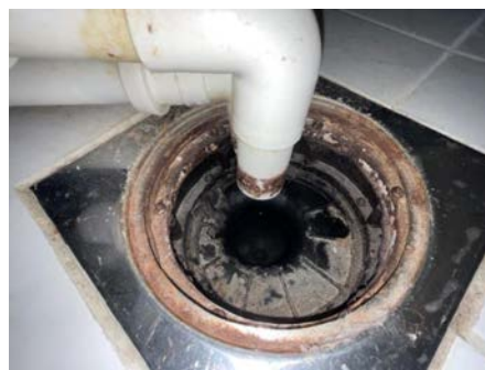
Sluk. Ikke mulig og avklare om membran er klemt under klemring.
