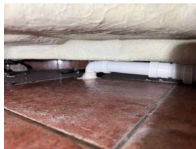
Rør fra dusjkabinett er ført i gulv til sluk.
