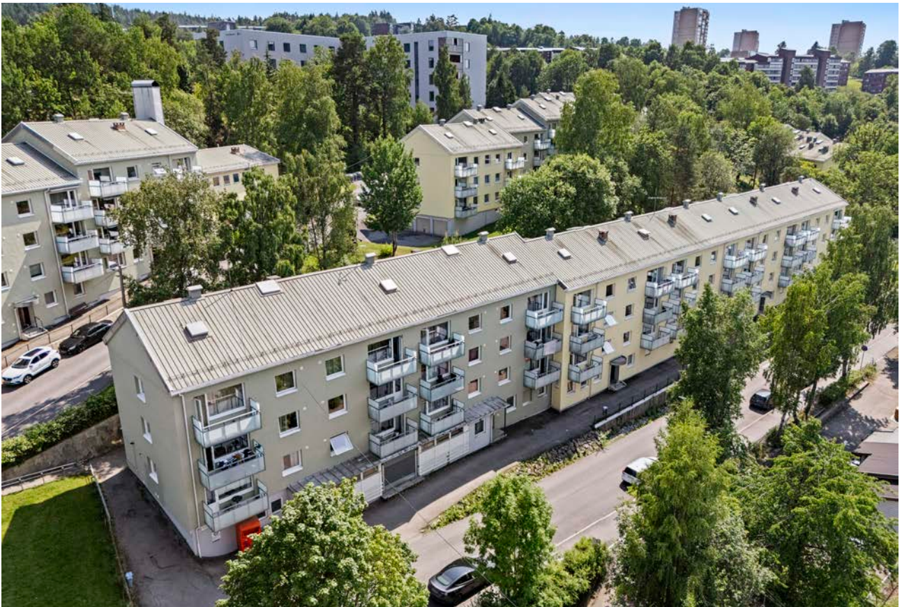
Bygningen har en saltakkonstruksjon med metalltekkede plater og utvendig pusset fasade.
