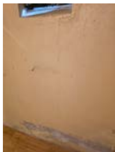
Synlig misfargning på nedre del av mur og dekke
