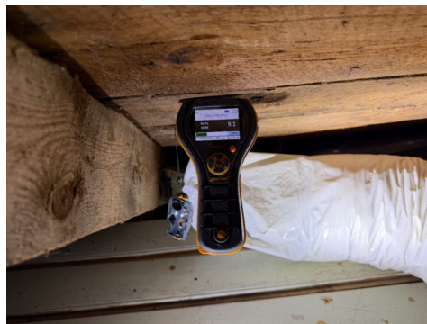
Fuktmåling i undertak, ikke utslag på fukt.
