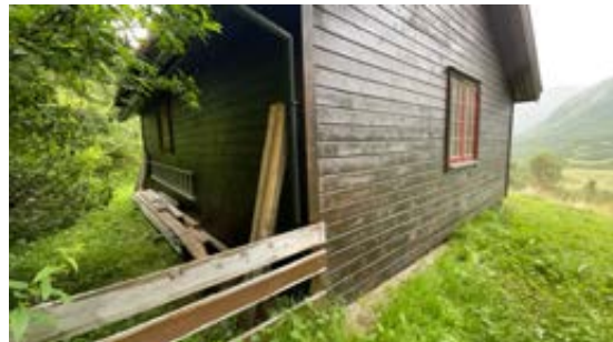
Bordkledning går stedvis nesten helt ned i terreng
