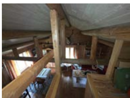
Oversikt takkonstruksjon fra hems mot stue
