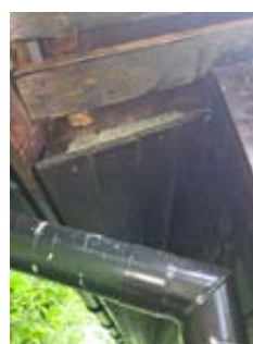
Synlig insektsduk på baksiden i raftekassen. Bildet viser overgang mellom takutstikk og raftekasse.
