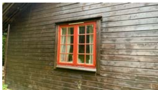
Vindu på gavelvegg stue har vannbrett i tre.
