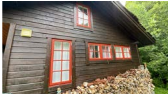
Vinduer på toalett og soverom.
