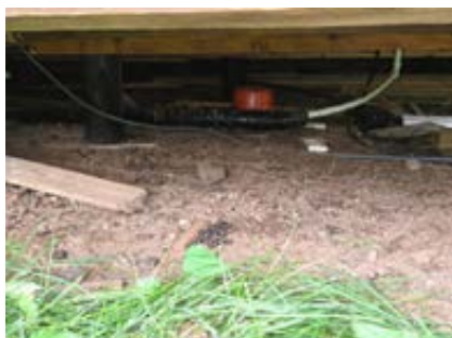
Pilar under hytta sett fra utsiden
