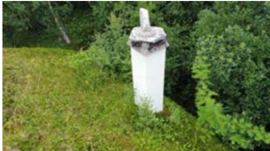
Pusset pipe med topphelle/toppstein og sokkelbeslag
