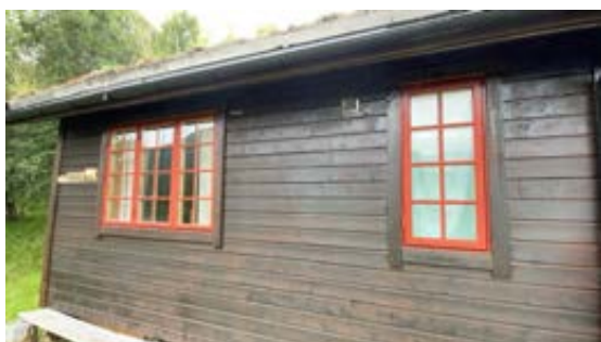
Vinduer på stue og vindfang.
