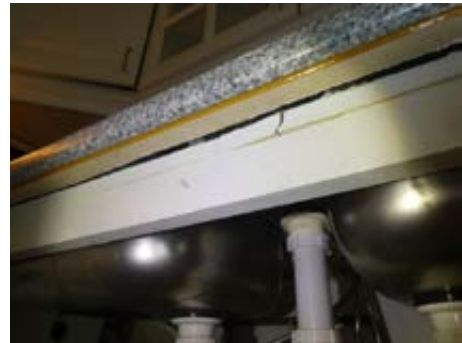
Liten skade på skrog under oppvaskkum
