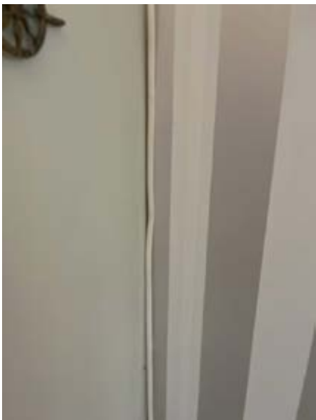
Sprekk i deksel på bryter
