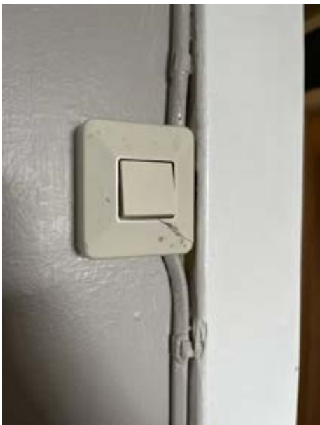
Sprekk i deksel på bryter
