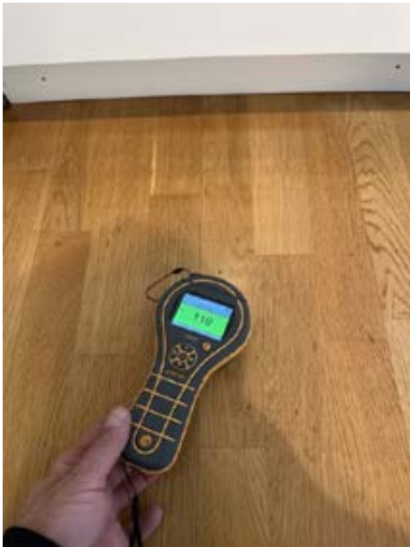
Ingen indikasjon på fuktighet i/rundt kjøkken
