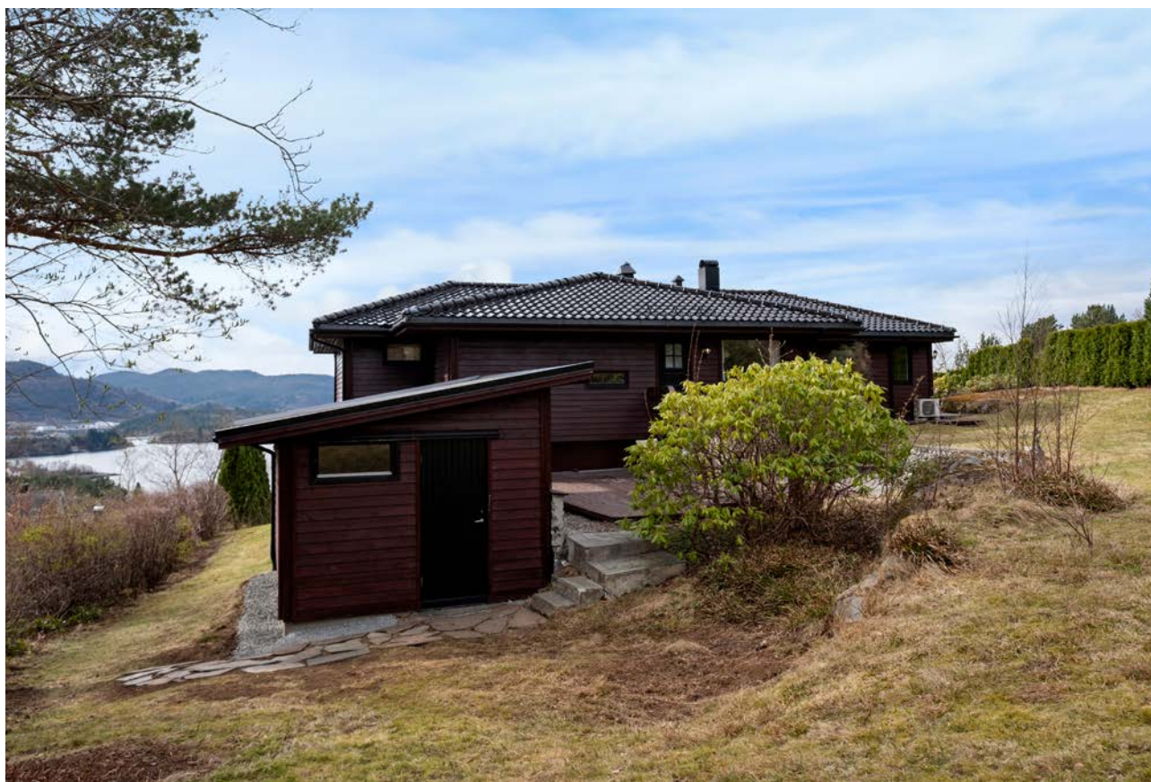
Uteboden er ikke byggemeldt
