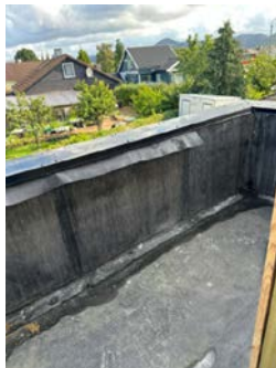
Lavt rekkverk på balkong ut fra 2. etasje
