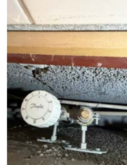
Justering av vannbåren varme i baderomsgulv
