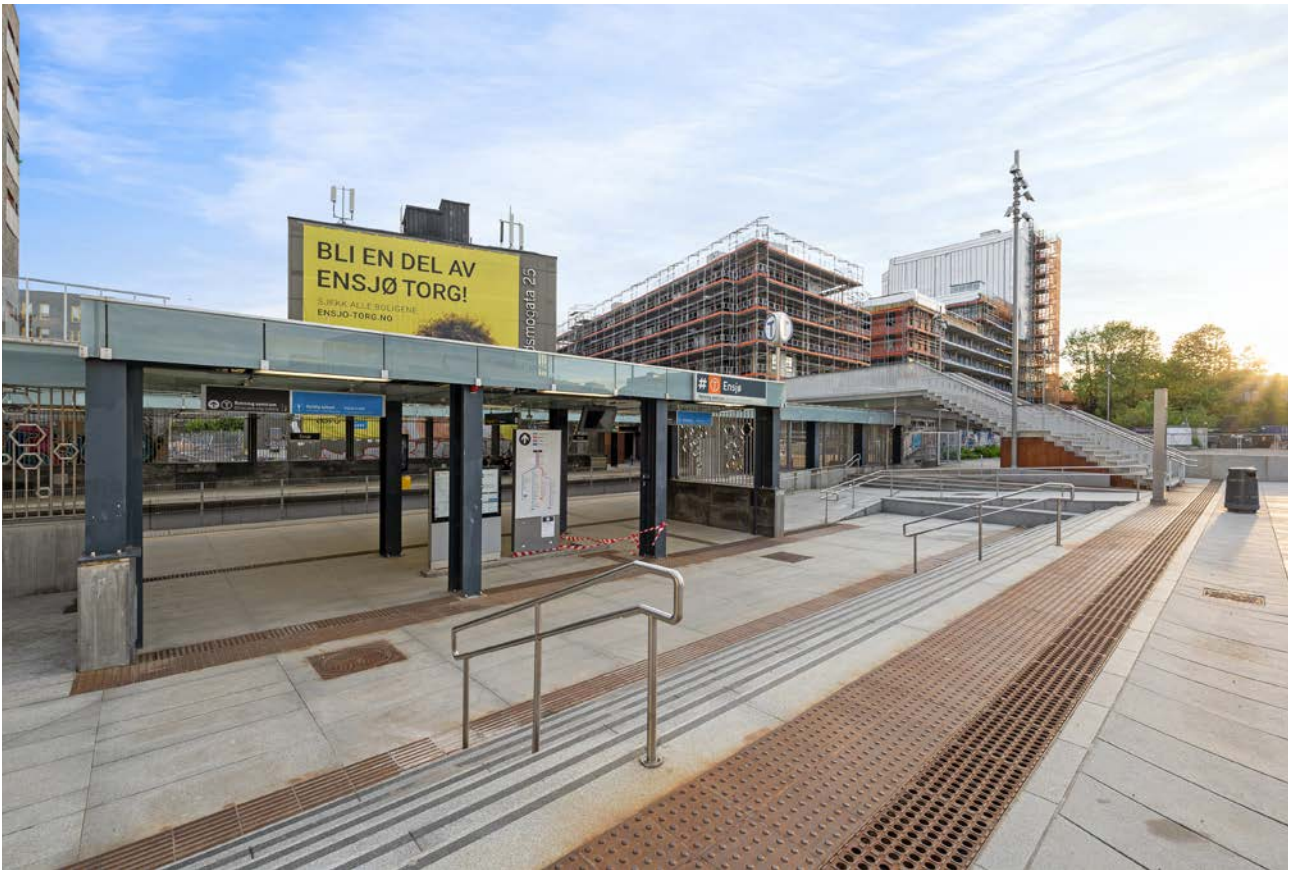
God dekning på offentlig kommunikasjon bare 14 min gange på T-bane fra Ensjo T-banestasjon hvor alle linjene stopper.
