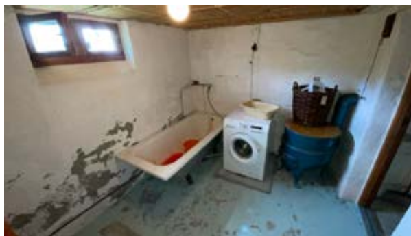
Vaskerom i kjeller.
