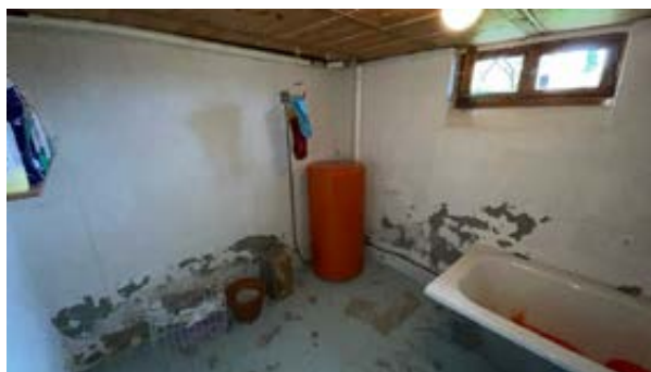
Vaskerom i kjeller.
