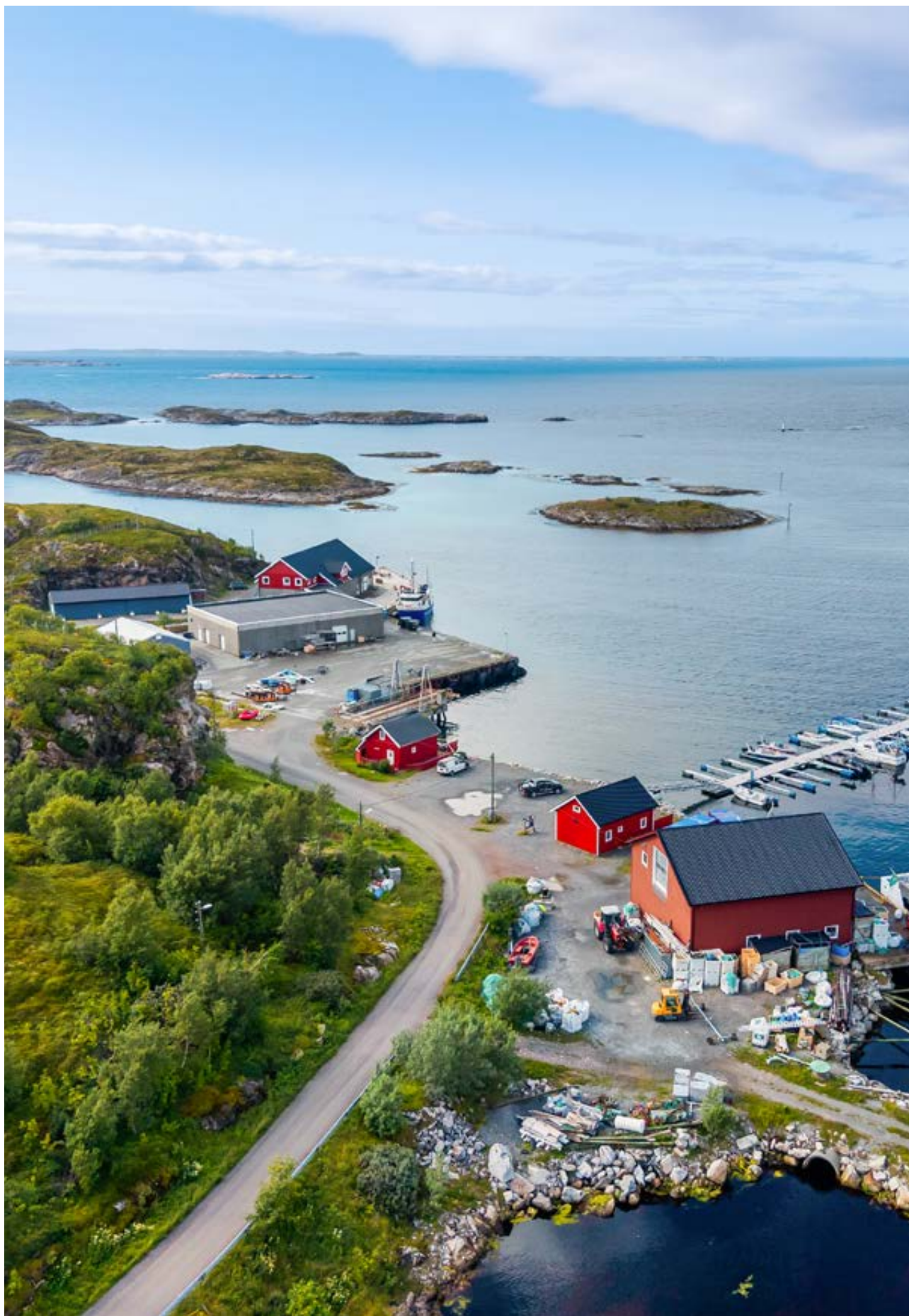
Dronefoto av kaianlegg , besøksbrygge, samt kai for hurtigbåt i bakgrunnen
