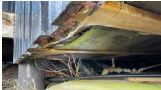
Vindsperre med åpning
