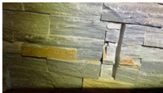
Gliper mellom element, bruk av mindre element
