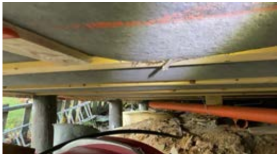
Vindsperre med åpning
