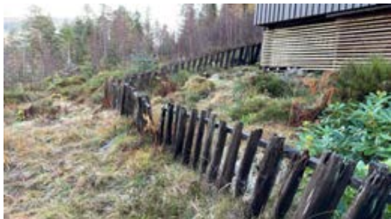
Gjerde i dårlig forfatning
