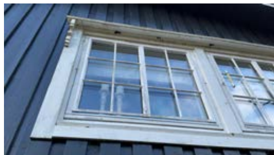
Værslitasje, svertesopp
