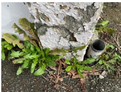
Avskalling i betong.
