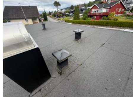
Oversiktsbilde av takteking.
