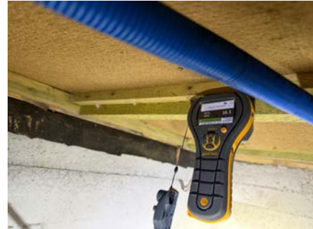
Fuktmåling i etasjeskiller i fra kryprom. Ikke utslag på fukt.
