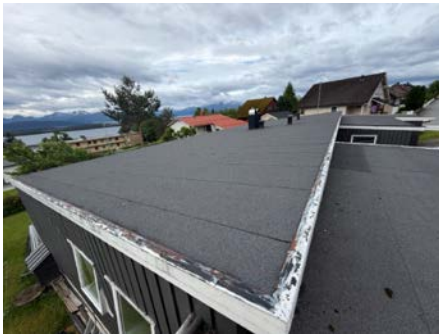
Oversiktsbilde av takteking.
