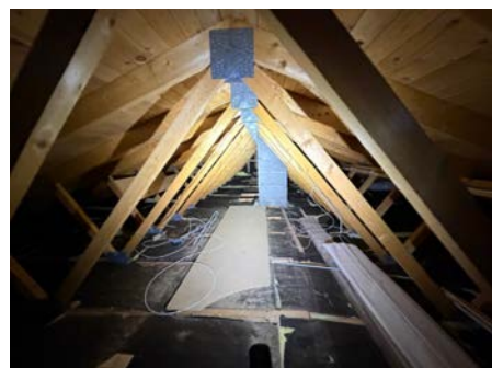
Oversiktsbilde av kaldloft.
