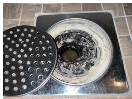
Sluk, synlig membran som er korrekt klemmt under klemring.
