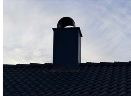
Skorstein over tak.
