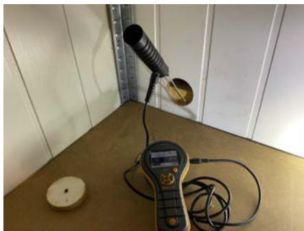
Hulltaking og fuktmåling.
