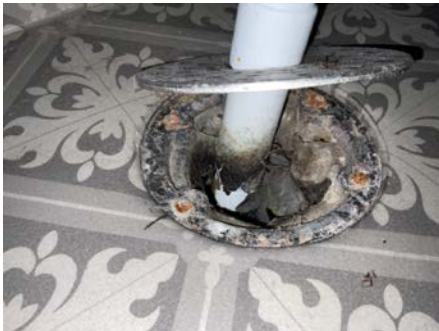
Sluk, vinylbelegg er korrekt klemmt under klemring.
