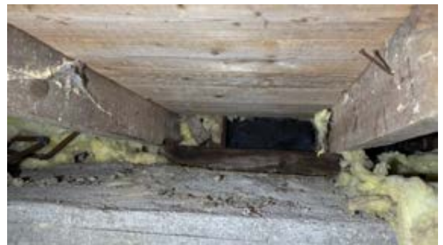
Råte i treverk oppå grunnmur i retning entreside.
