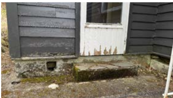
Ved utgang bakgang. Krypkjeller uten tilgang (ventil)
