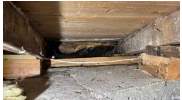
Råte i treverk oppå grunnmur i retning entreside.
