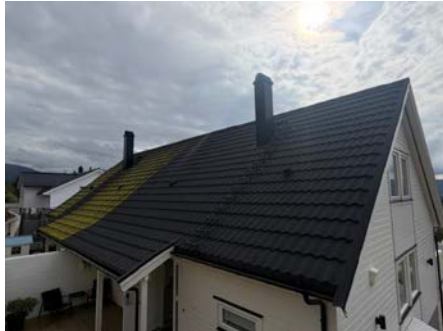
Oversiktsbilde av takteking mot nord.
