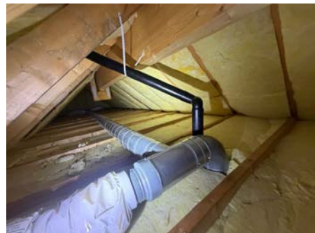
Oversiktsbilde av loftet.
