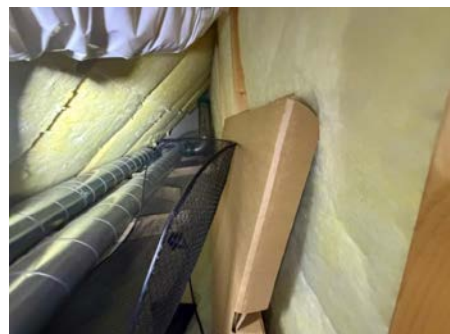
Oversiktsbilde, ett av raftekottene.
