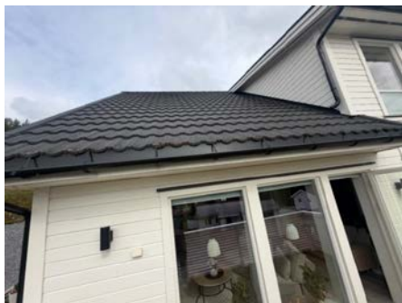
Oversiktsbilde av takteking mot sør.
